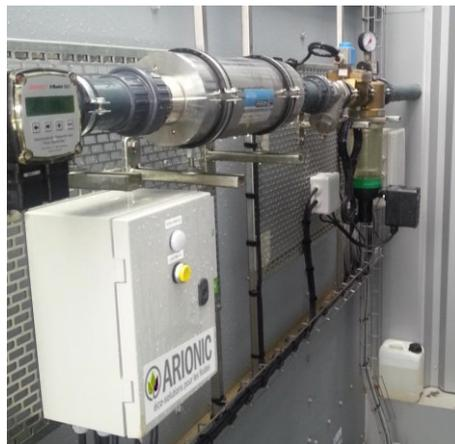
Figure 6 : Boîtier New Ionic Water installé sur une grille d'approvisionnement en eau
